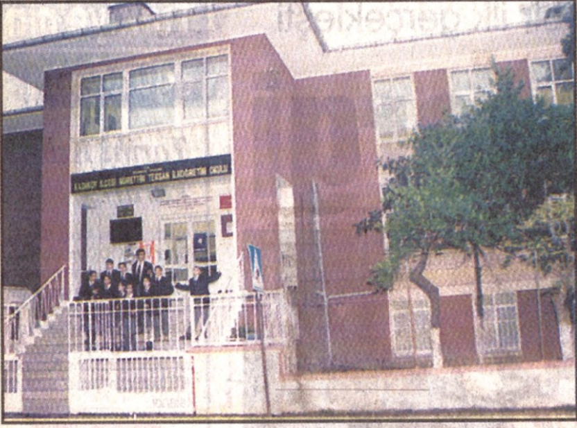
38 yıllık okul binası hayırsever vatandaş Nurettin Teksan tarafından yaptırıldı
